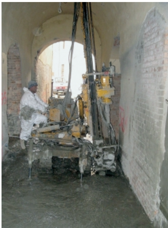
Fig. 2 Sottofondazioni con colonne "MINIJET" Underpinning with "MINIJET" columns (Modena, MO – Italy)
