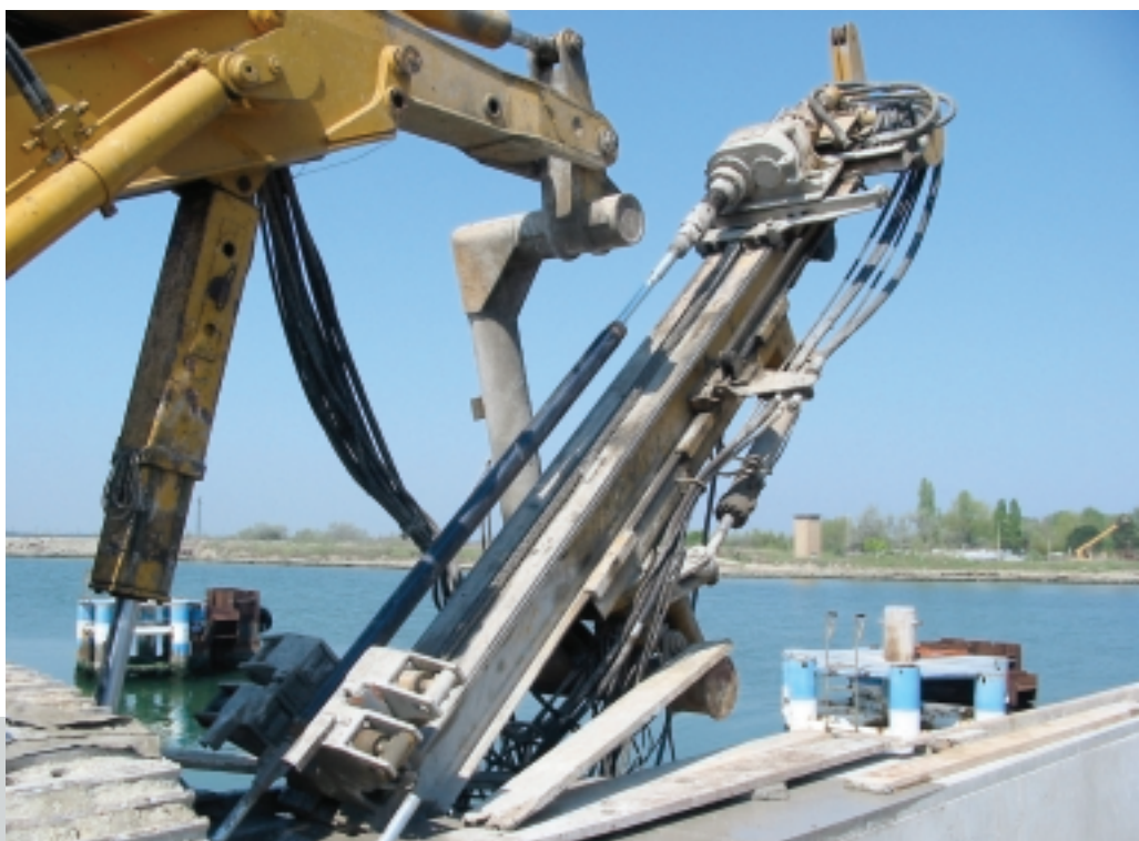
Fig. 7 Tiranti attivi per molo portuale Active anchors for a pier (Ravenna, RA - Italy)
