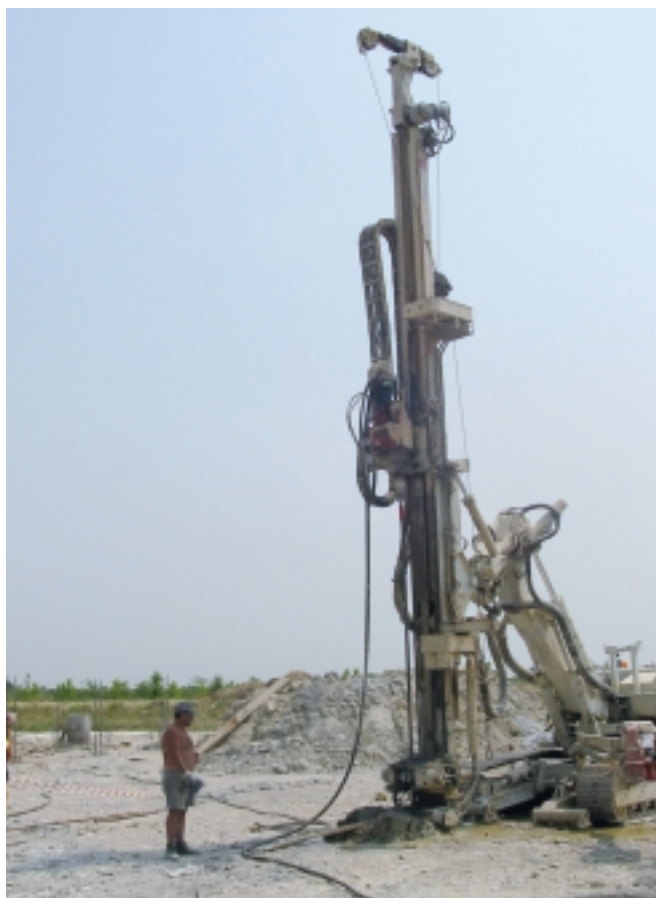
Fig. 3 Tiranti passivi "MINIJET" "MINIJET" tie-down (Mogliano Veneto, TV – Italy)
