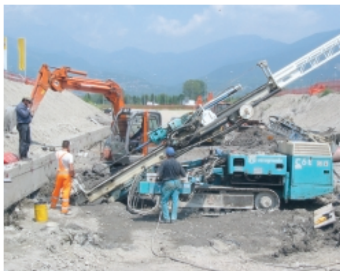
Fig. 5 Campo prova tiranti attivi per sottopasso stradale Active anchors field test for a road underpass (Avigliana, TO – Italy)
