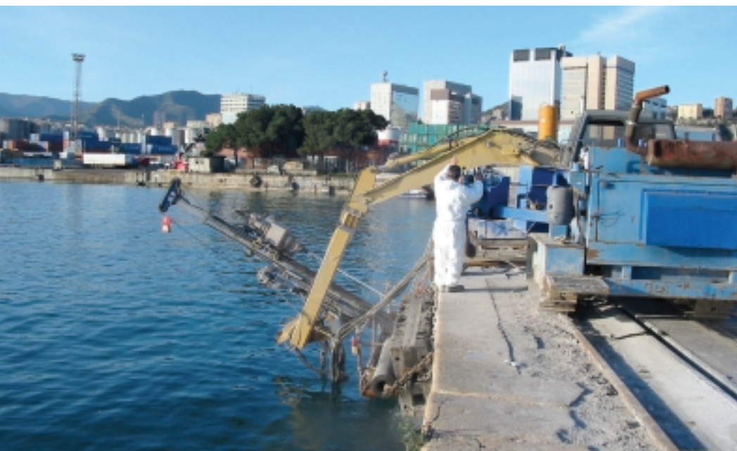
Fig. 7 Tiranti attivi per molo portuale Active anchors for a pier (Ravenna, RA - Italy)
